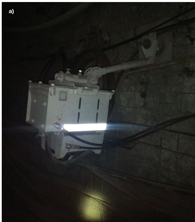
Рис. 1. Базовая станция – основной компонент для организации подземной инфраструктуры связи (кабельной и беспроводной) в системе наблюдения, оповещения и поиска людей, застигнутых аварией, «SBGPS»: а) – вид общий; б) – технические характеристики
